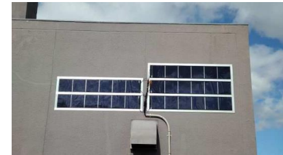
研究開発センター構内の建物壁面に設置したフィルム型ペロブスカイト太陽電池
